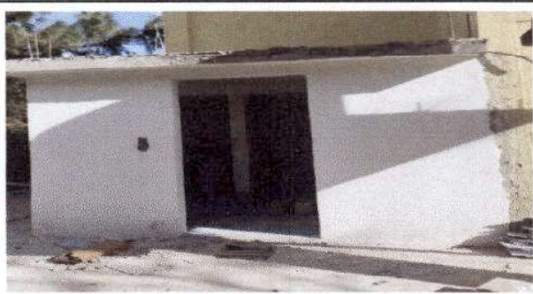
Foto 1: Fabricación e instalación de puertas de metal en baños.
