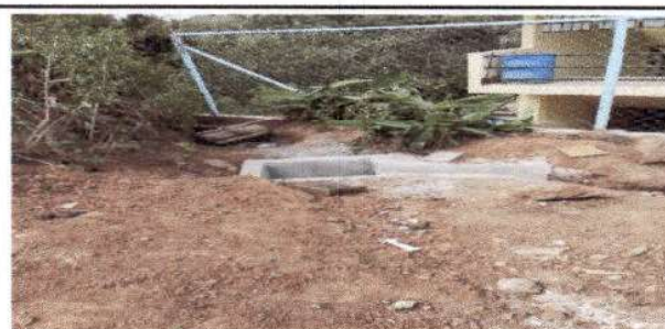
Foto 5: Reparación de bajadas de agua pluvial, tubo y caja de registro
