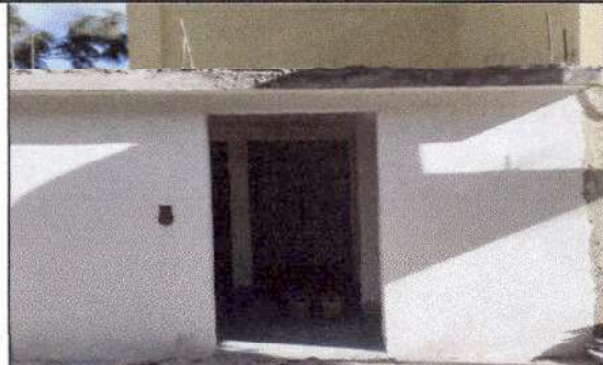
Foto 2: Sustitución de piso o torta de concreto
