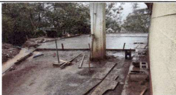
Foto 3: Reparación de planchas de concreto de patio.
