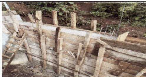
Foto 4: Reparación de muro de Contención.
